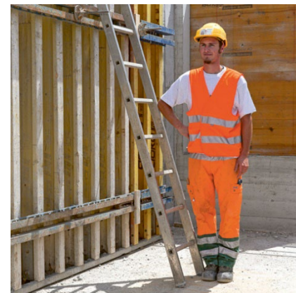
Überprüfen des Anstellwinkels mit der "Ellbogenprobe"
