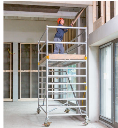
Beispiele von sicheren Rollgerüsten
