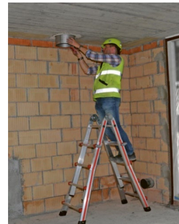
Beispiel einer Kombileiter, als Bock- oder Anstellleiter verwendbar (Betriebsanleitung beachten)
