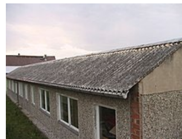
Dach aus Asbestzement-Dachwellplatten
