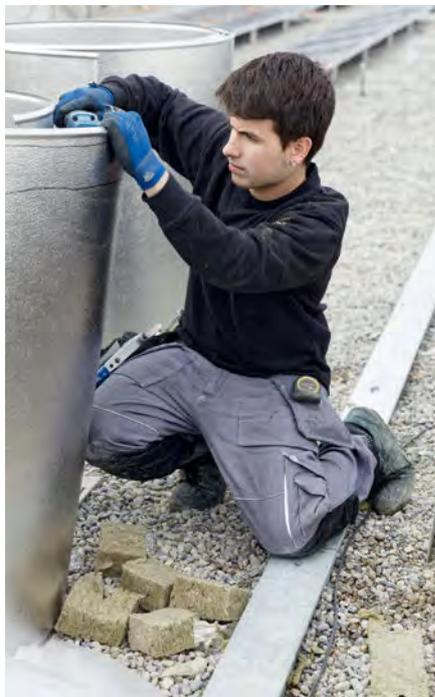
fixieren. Darüber kommen gerundete, dünne Platten aus leichtem Aluminium-Blech. Auch diese sind bereits zugeschnitten. Joel Da Costa und seine Kollegen befestigen eine nach der anderen mit Nieten.
